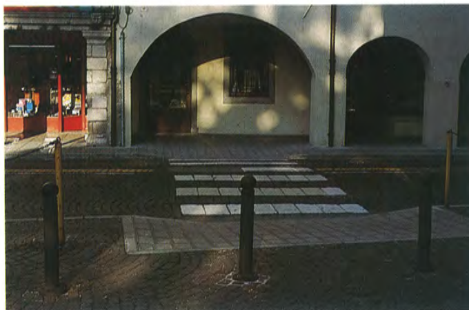
Rampette in pietra su attraversamento pedonale
