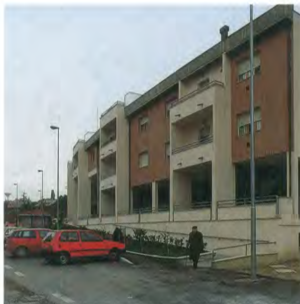
L'edificio dalla strada: la rampa porta al portico
