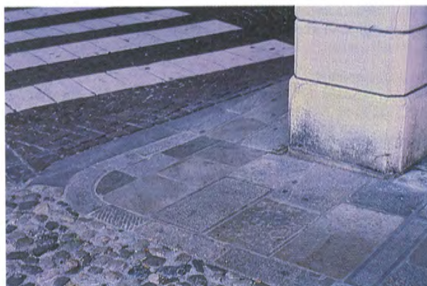
Adeguamento mediante raccordo della pavimentazione
