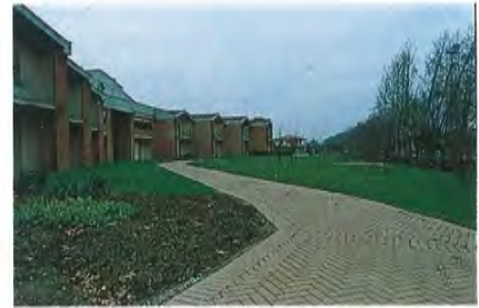
Veduta delle residenze disposte a schiera
