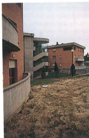
L'edificio dal giardino: al centro la rampa ed i percorsi verticali
