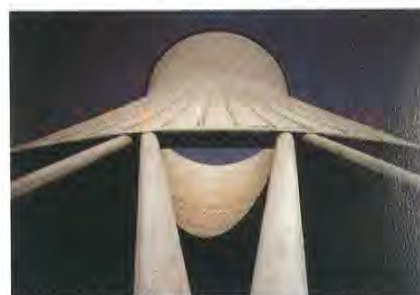
L'iperboloide: scorcio di un refrigeratore della centrale di Bugey
