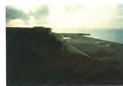
Orizzonti lontani: la centrale di Penly
