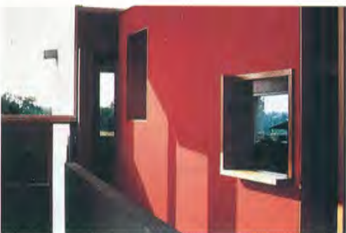
"Ballatoio fluttuante" al 3° piano
