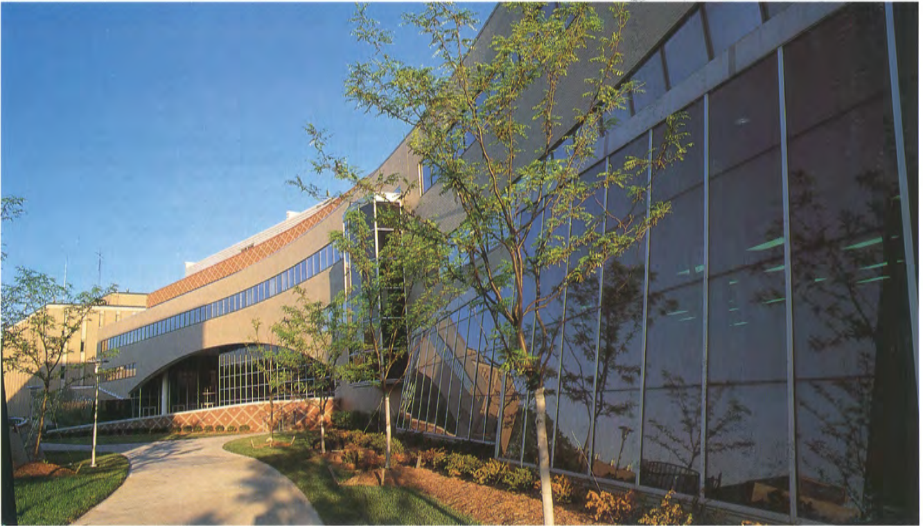
Veduta lungo il prospetto nord da "Crushed Windows" fino a "Graphic Arch"
