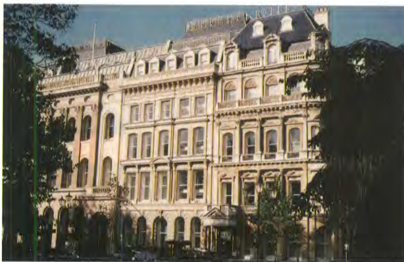
Edifici per uffici costruiti negli anni '90 dietro la facciata di palazzi della metà del XIX secolo nel centro di Birmingham (foto 1995)
