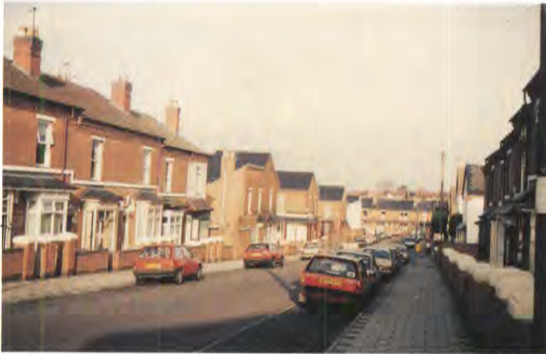
Anni '80: rifacimento degli esterni di case a schiera, mura confinarie dei giardini e selciato, tutti di epoca tardo-vittoriana, a Birmingham, con i finanziamenti delle amministrazioni locali (foto 1992)
