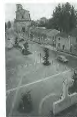
49-50: Piazza della Bicocca - S.S. 211, Novara. Situazione antecedente e successiva alla sistemazione della mobilità ai fini di una rifunzionalizzazione urbana
