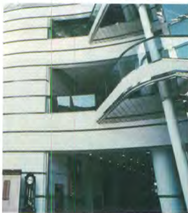
Seul - Lobby, sede centrale Lucky Goldstar Corporation. Pannelli verticali, piani e curvi
