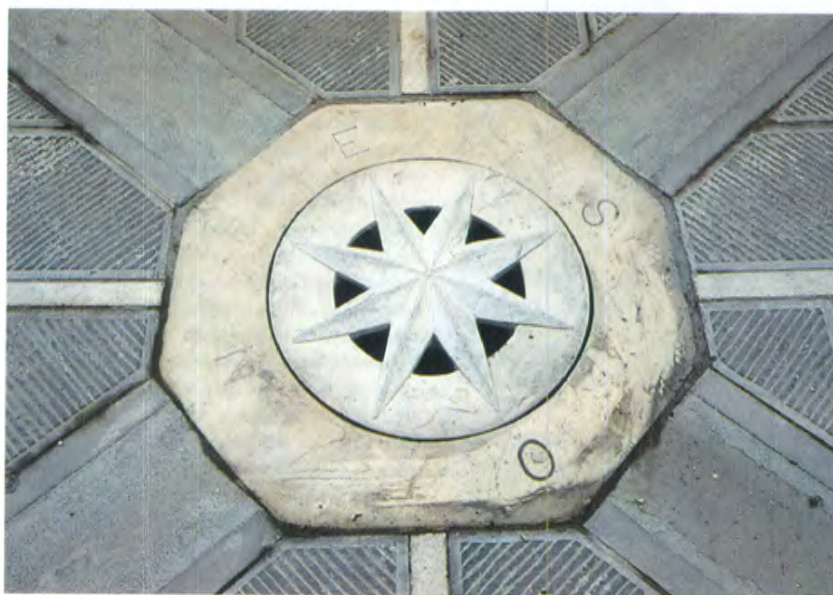
La caditoia centrale realizzata al centro della piazza S. Maria su cui convergono le diagonali tracciate partendo dai limiti originari della piazza.
