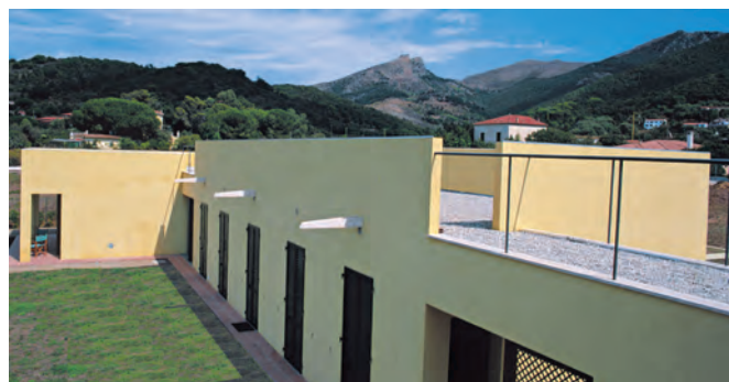
Casa a Le Trane, scorcio della copertura – solarium
