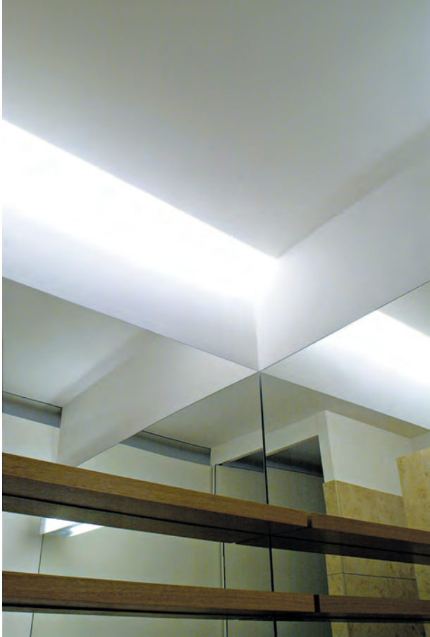
Particolare del controsoffitto in gesso
