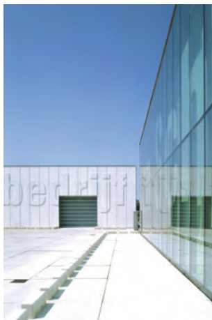
Claus en Kaan Uffici e magazzino Van Schaik Breukelen, Paesi Bassi
