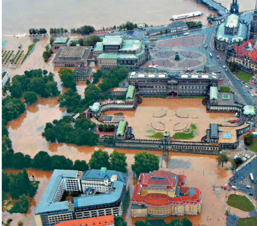
Dresda Allagamento della città storica nell'agosto 2002
