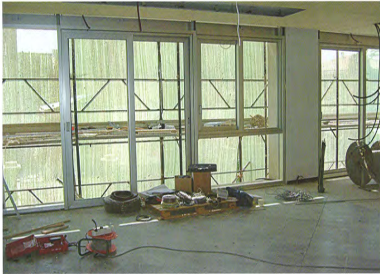
Una fase del montaggio in cantiere delle facciate continue
