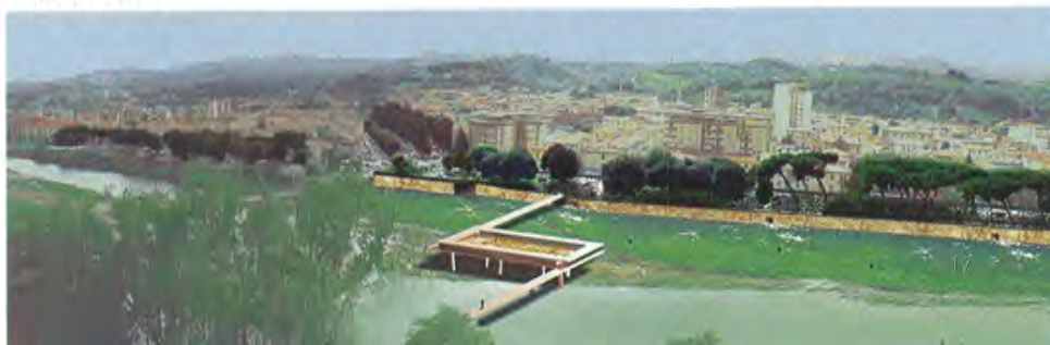
San Giovanni Valdarno / laN+ (Carmelo Baglivo e Luca Galofaro). Gli argini trasparenti e il ponte abitato
