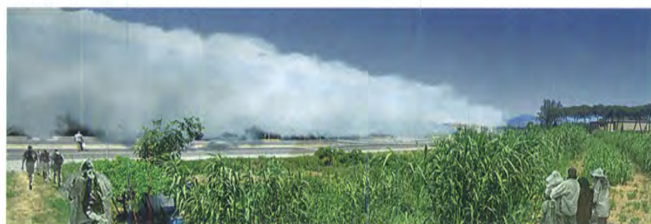
Lastra a Signa / ma0 (Alberto Iacovoni, Luca La Torre). "S.O.S.: Signe operazione suolo", il viadotto
