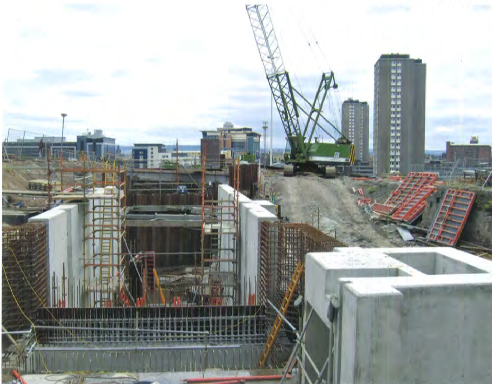
Speirs Wharf, lavori per la costruzione del tratto del canale tra Speirs Wharf e Port Dundas
