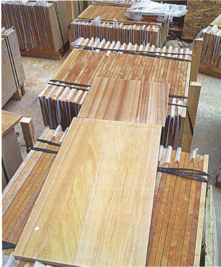
La fase della cernita in cantiere ha permesso di selezionare le lastre: contemporaneamente si provavano ad accostare le lastre una all'altra per cercare di dargli un effetto visivo di continuità. Quelle che risultavano troppo chiare o troppo scure venivano scartate e utilizzate per rivestire il muretto di recinzione del giardino, le banchine delle finestre in facciata ecc.
