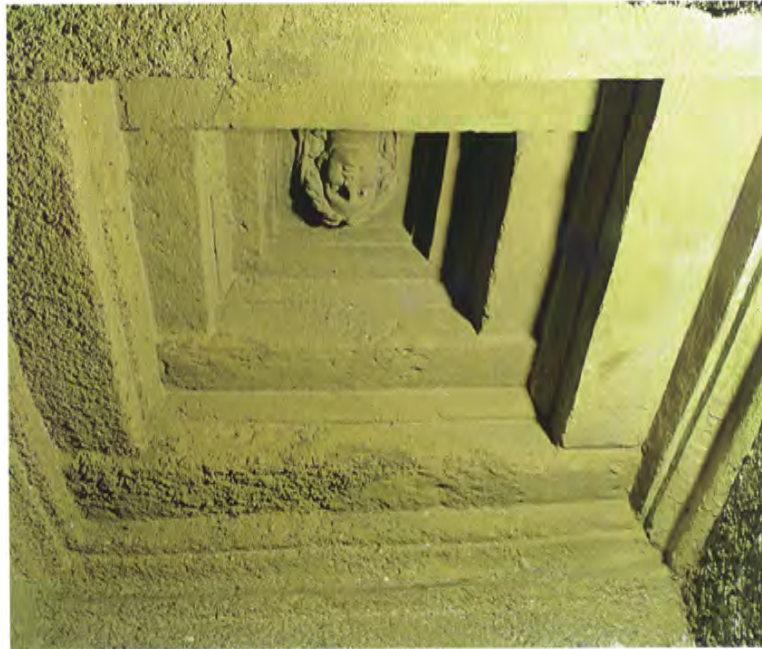
Vista del soffitto a lacunare con sistema "a travi rientranti" con figura a rilievo nell'ala destra
