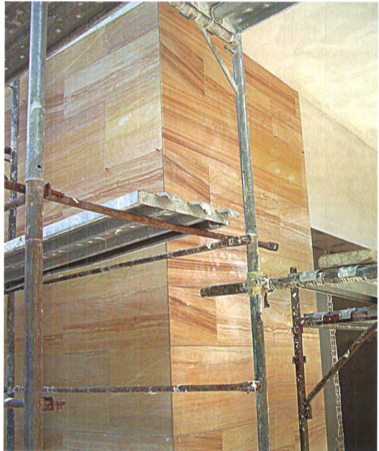
La prova in cantiere del montaggio e dell'accostamento delle lastre
