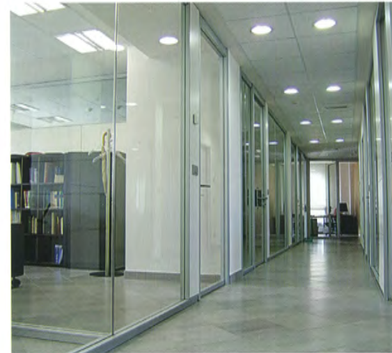
In primo piano l'interessante soluzione estetica della giunzione a T dei vetri senza l'uso dei montanti
