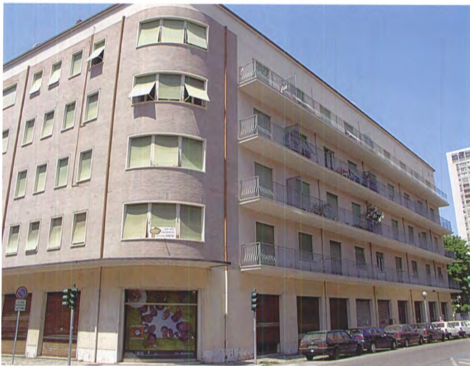
L'edificio originale, come si presentava prima dell'intervento di completa demolizione e ricostruzione
