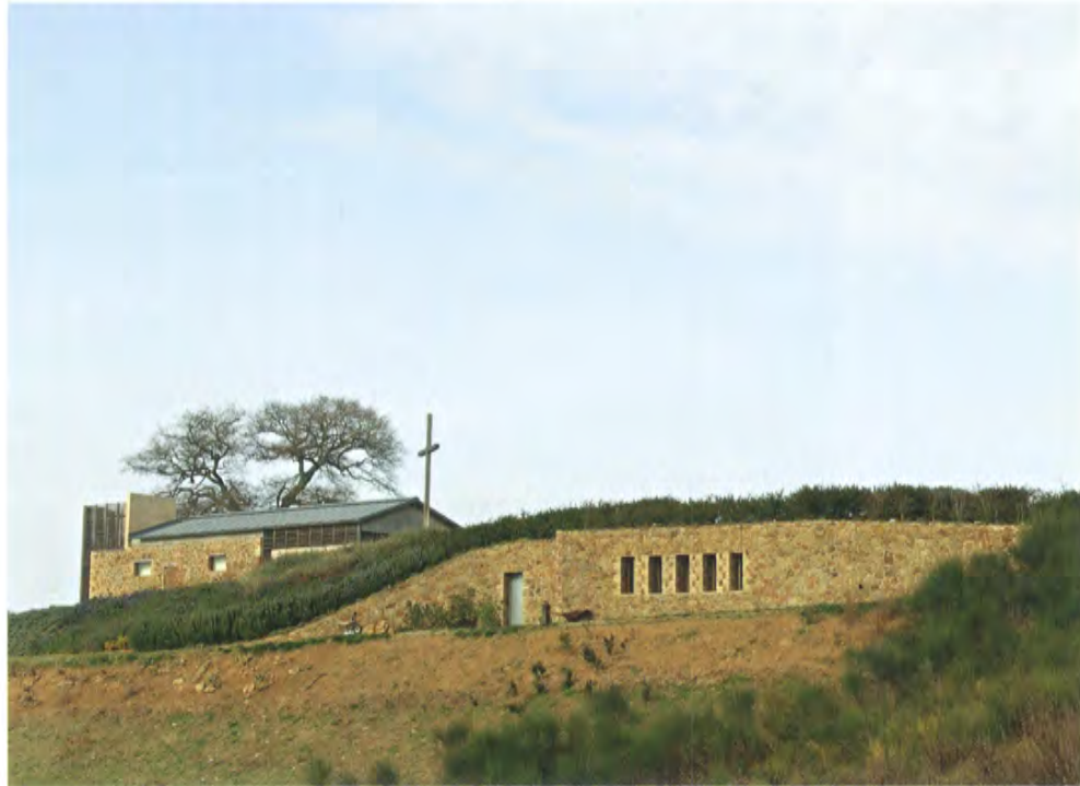
Cappella del Pellegrino e servizi igienici interrati. Foto Francesca Perani
