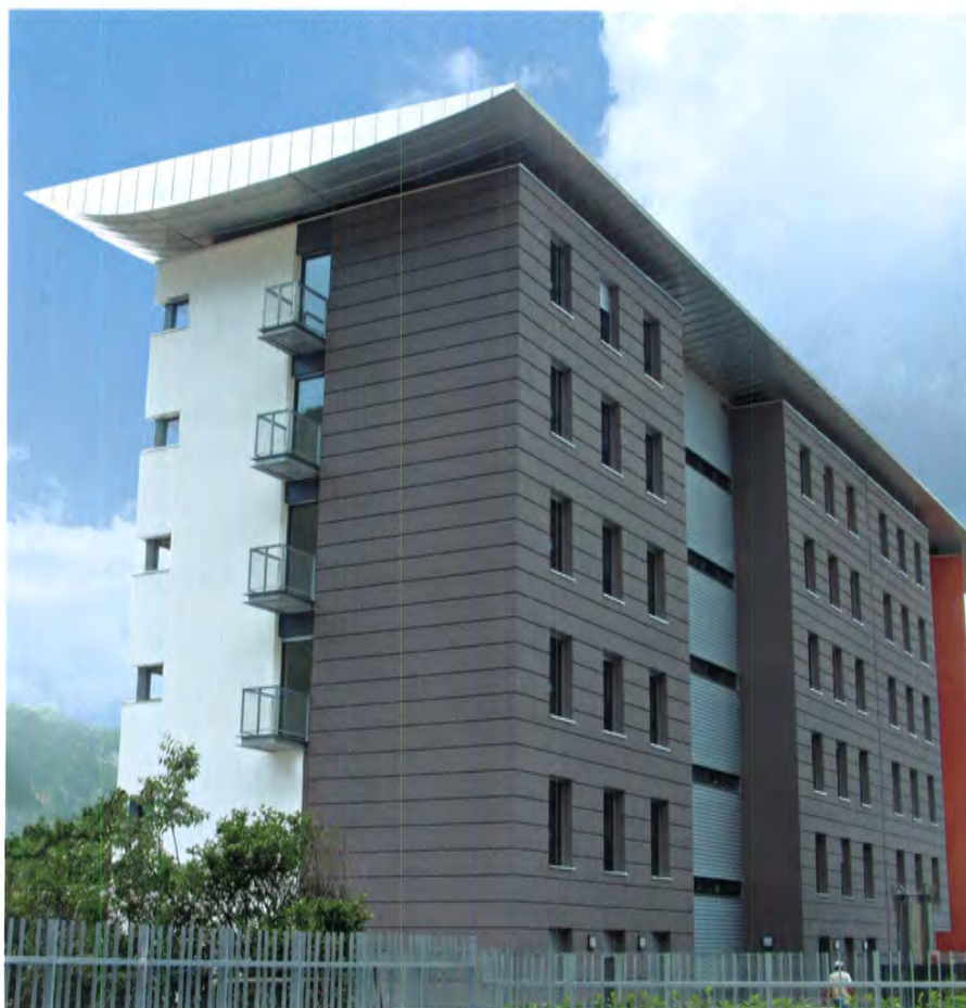
Vista nord-est. Nei corpi a nord le zone notte e i vani scala
