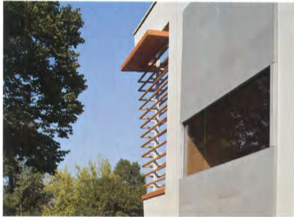
Dettagli della "fioriera" e dei frangisole metallici
