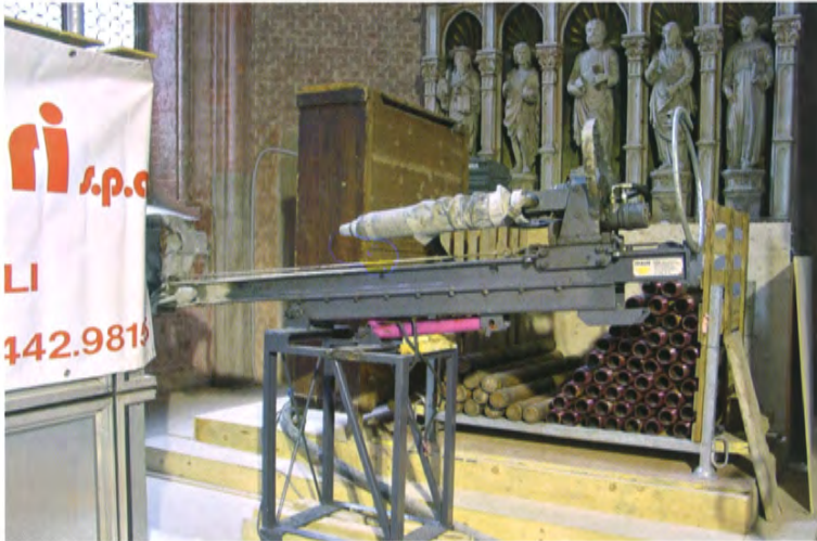
Smontaggio della trivellatrice per consentire l'utilizzo manuale nelle zone più interne della Basilica
