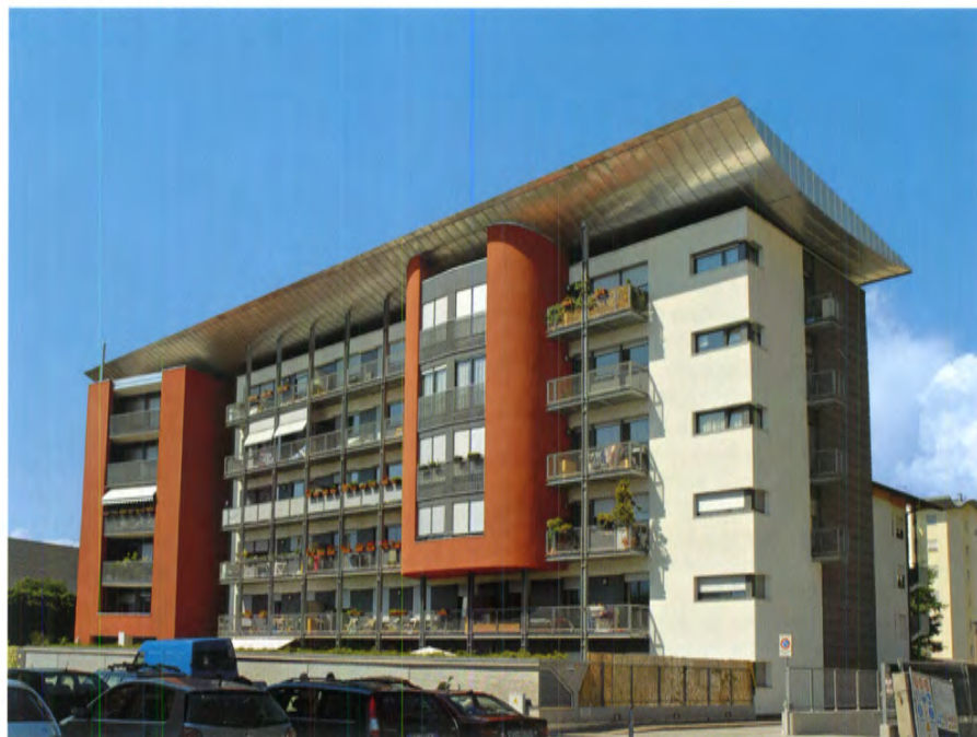
Vista d'insieme da sud-est
