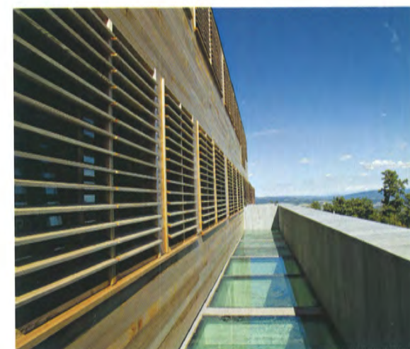
Parete ventilata in cedro (monastero). Foto Paolo Da Re
