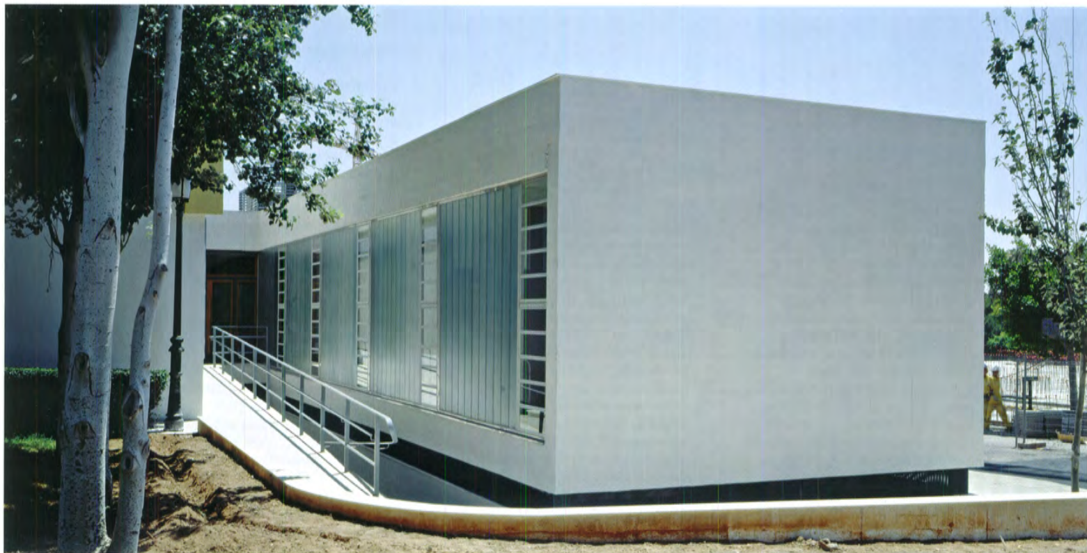
Veduta da nord-est
