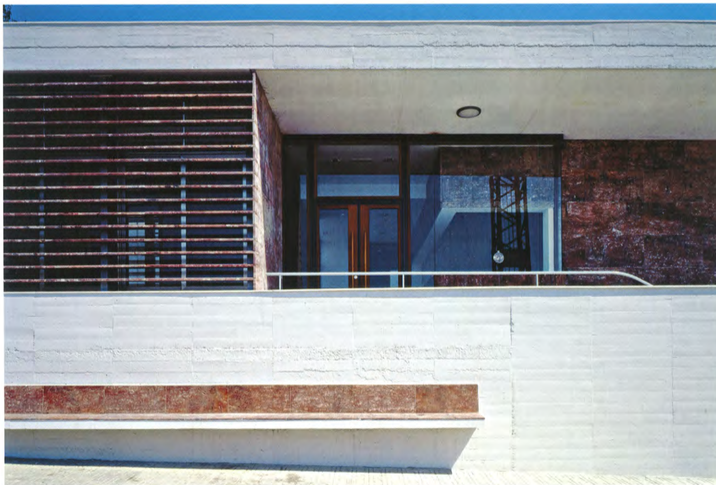
Particolare dell'ingresso; la schermatura del ponte sud è ottenuta con lame orizzontali in pietra rossa locale
