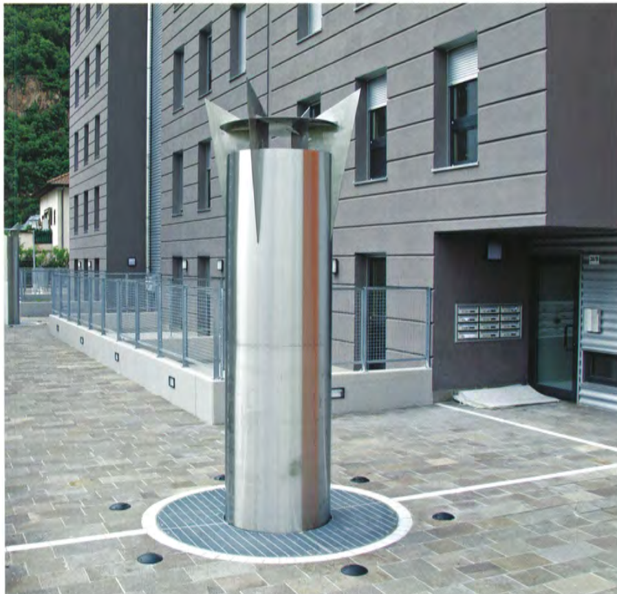
Ingressi sul fronte nord. Ingressi ai vani scala con le relative prese d'aria per gli impianti di ventilazione
