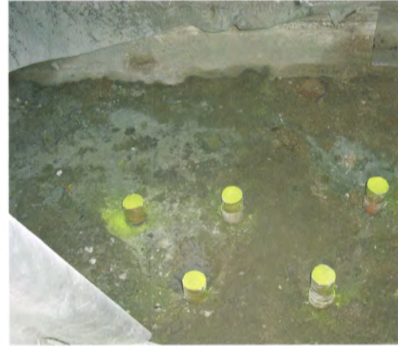
Testa delle canne valvolate sul lato interno della Basilica, nello spazio retrostante alla cappella di San Pietro
