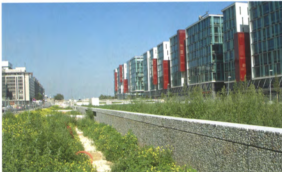
La costruzione della nuova promenade e dei giardini della terrasse 17
