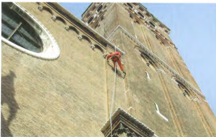
I rocciatori controllano lo stato del paramento esterno del campanile della Basilica
