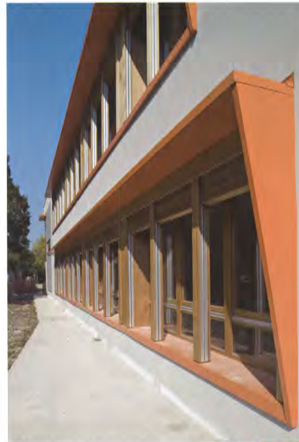
I sistemi frangisole regolabili
