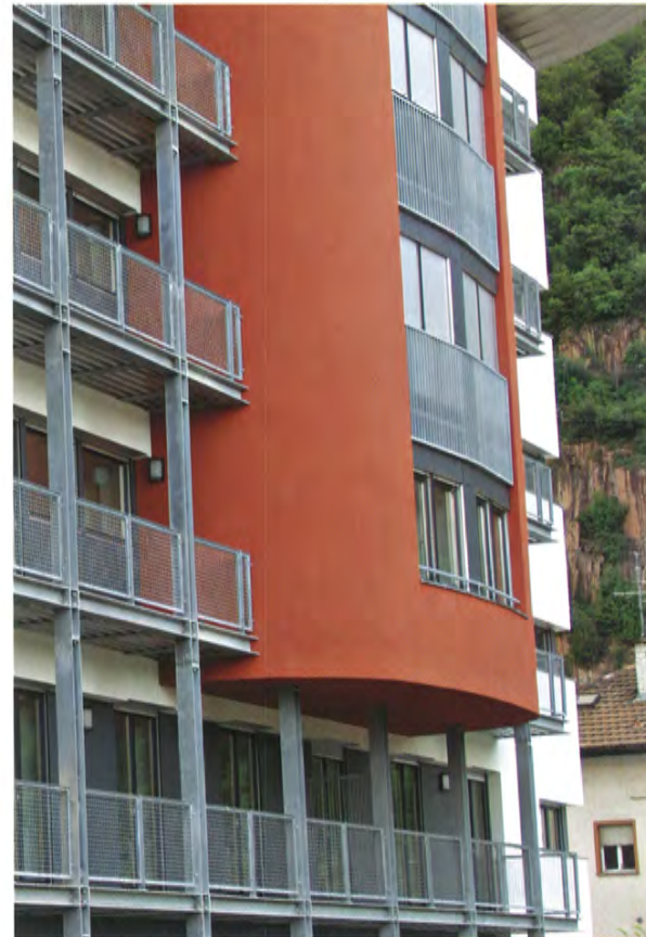
Dettaglio prospetto sud. Griglia metallica delle balconate di schermatura
