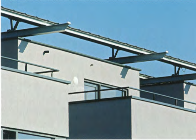
Il blocco residenziale con il "tetto energetico" in moduli fotovoltaici, sostenuti da un sistema di travi in acciaio
