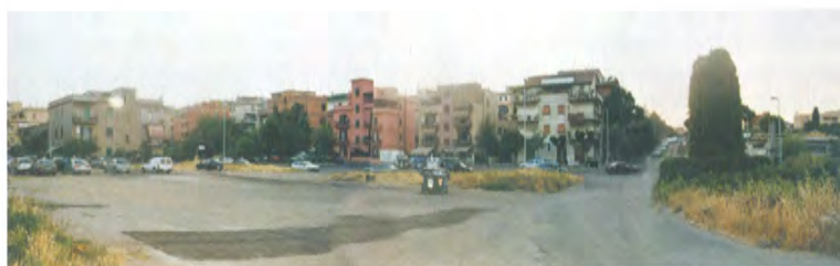
L'area prima dei lavori. L'immagine mostra lo stato di degrado di questo spazio prima dell'intervento e i resti dell'acquedotto che erano disposti nell'asfalto fungendo da spartitraffico della strada
