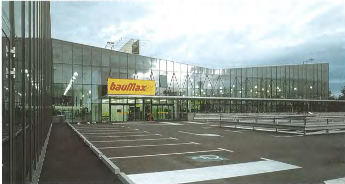
Baumax a Maribor, architetto Hrvoje Njiric. Veduta della corte principale e dello schizzo concettuale
