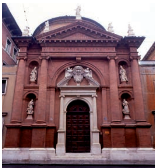
La facciata della chiesa di San Carlo a Ferrara prima e dopo gli interventi di restauro
