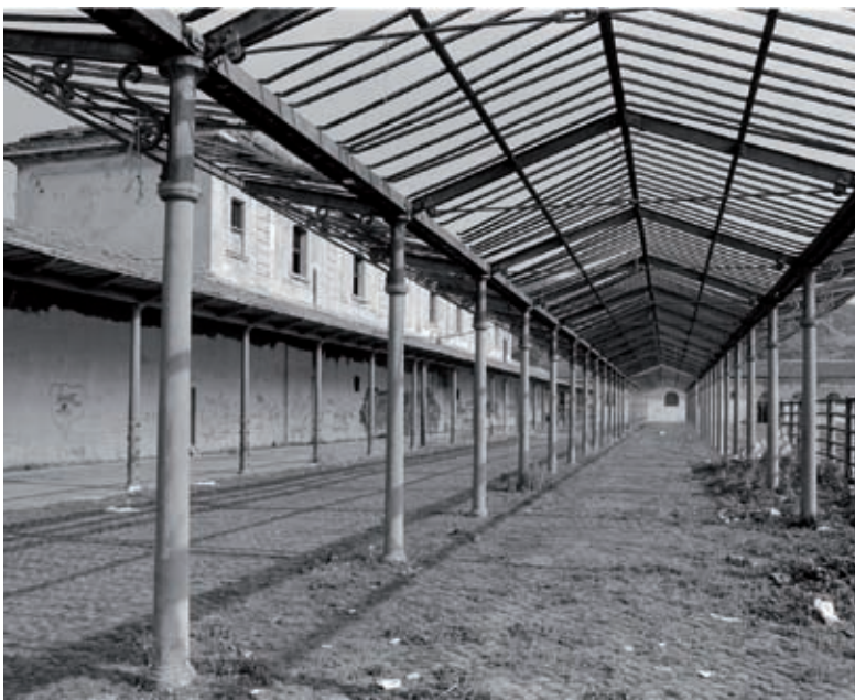
L'area di intervento e le colonne in ghisa risanate tramite la cucitura meccanica delle lesioni e l'inserimento di nuove fusioni
